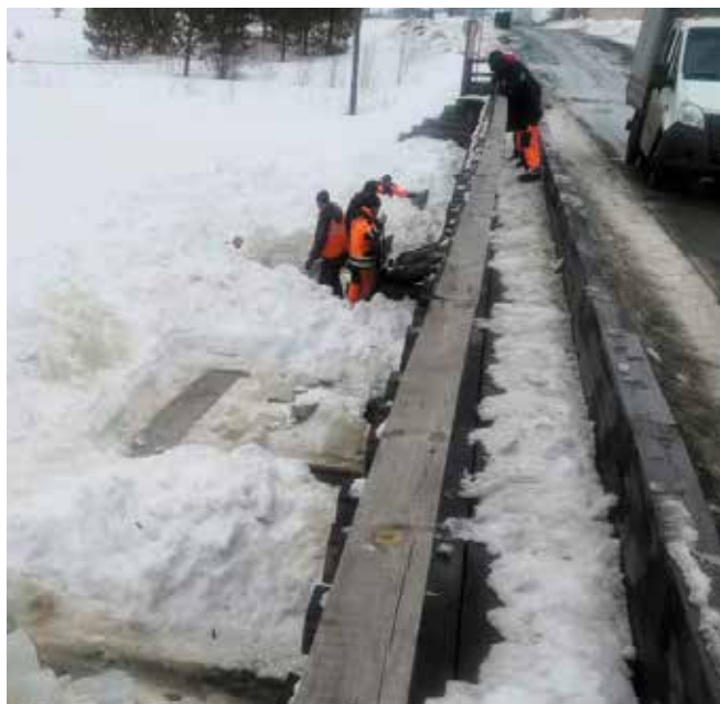
Автомобильный мост через реку Ялынка
